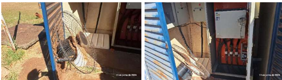
P10 – Ventilador improvisado para refrigeração do circuito de comando da bomba do poço
