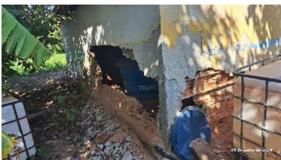
CRD06 – Sistema de tratamento – Paredes desabando pelo efeito da corrosão do cloro
