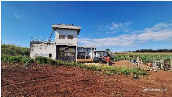
Vista geral da entrada da ETE
