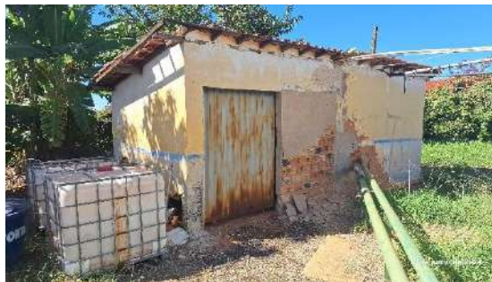
CRD06 – Sistema de tratamento – Paredes desabando pelo efeito da corrosão do cloro
