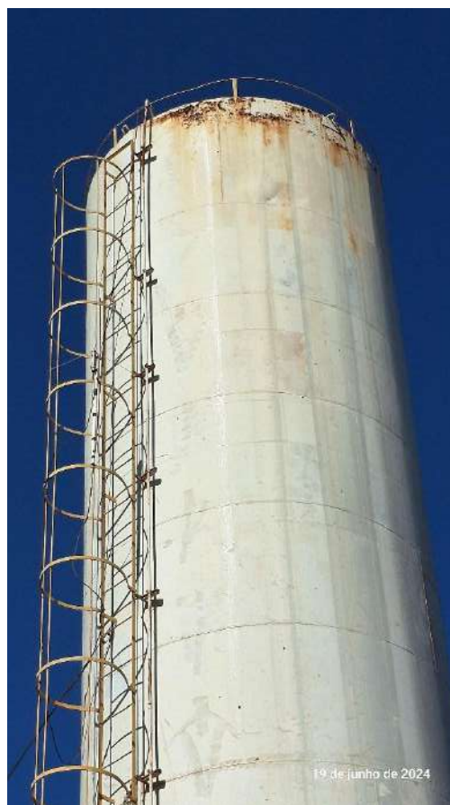
CRD02 – Reservatório com pintura degradada e com pontos de ferrugem
