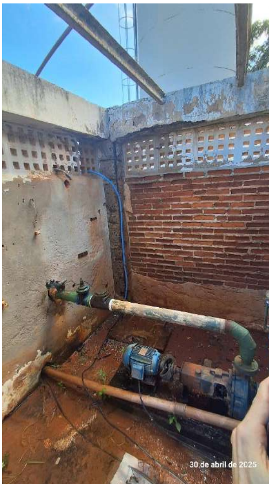
CRD02 – Vista Geral do reservatório e da casa de máquina alagada e sem cobertura
