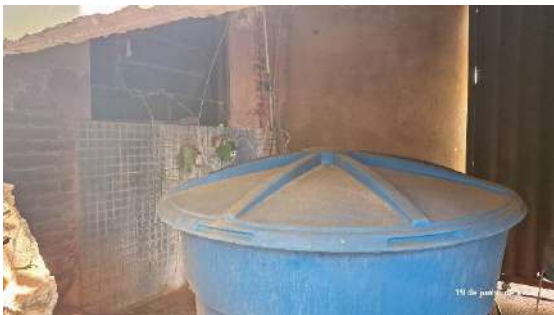
CRD06 – Sistema de tratamento – Paredes desabando pelo efeito da corrosão do cloro
