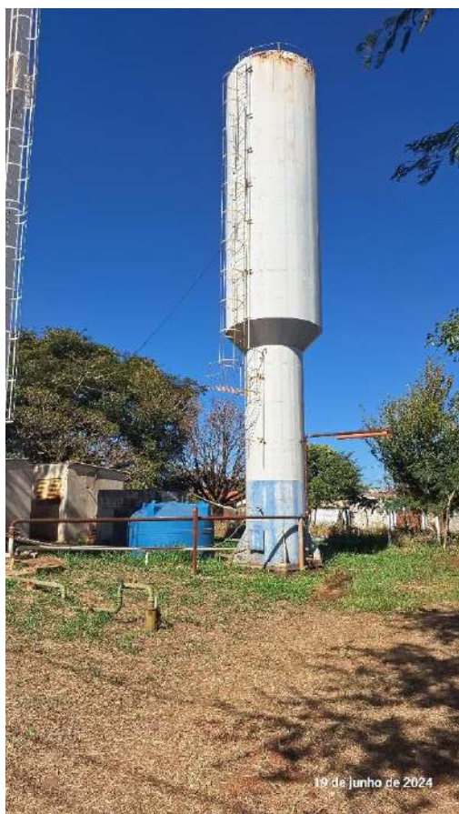
CRD02 – Reservatório com pintura degradada e com pontos de ferrugem
