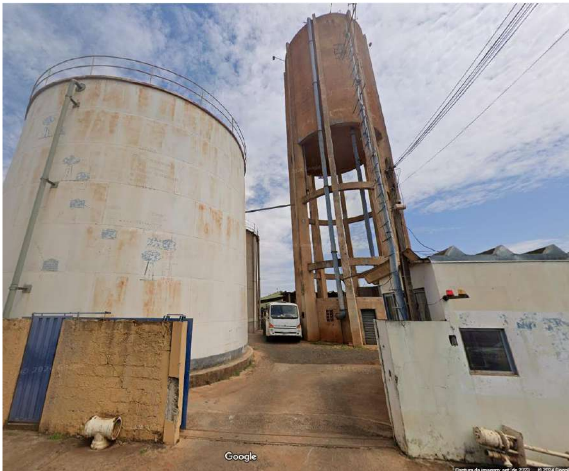
CRD01 – Vista Geral do portão de entrada
