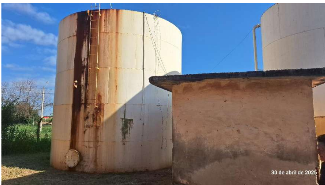
b) Reservatório com grande volume de oxidação:
