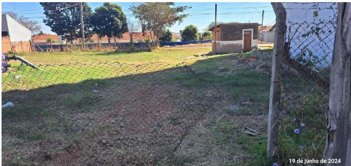
P09-A – Ausência de portão adequado. Área fechado com alambrado amarrados com arame
