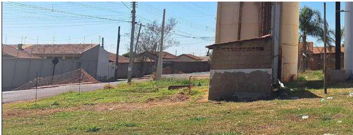
P09-A – Vista Geral do local – Falta de segurança por ausência de alambrado – Vista em detalhe
