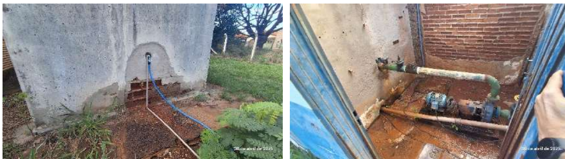
CRD02 – Vazamento
