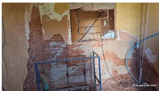
CRD06 – Sistema de tratamento – Paredes desabando pelo efeito da corrosão do cloro
