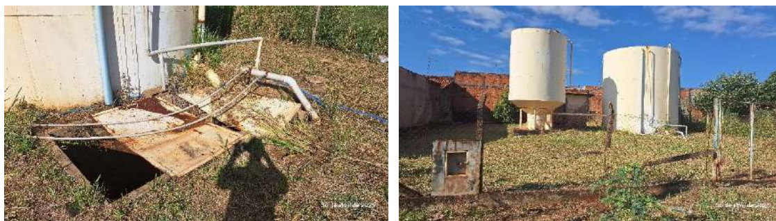
b) Reservatório com grande volume de oxidação:
